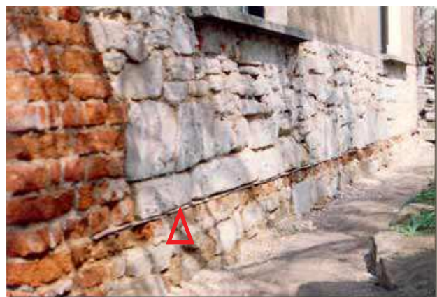
Bild 25 In eine Fuge eingeschlagenes Edelstahlblech
