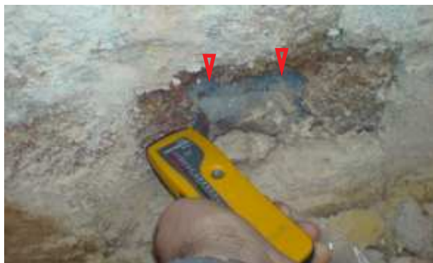
Bild 24 Freigelegtes Verkieselungs-Gel in der Wand. Das Messgerät zeigt Wassersättigung der Poren
