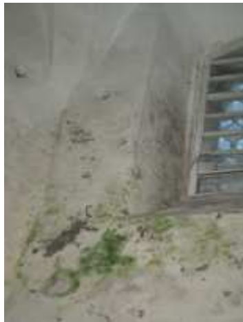
Bild 6 Sergieva-Klosterkirche, Hangstützwand vor Einbau der Isophob-K -Flächensperre
