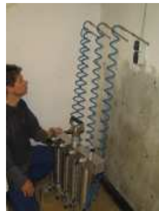
Bild 4 Maschinelle Injektion von Isophob K
